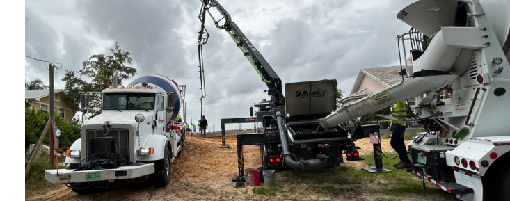
POURING THE SLAB!
